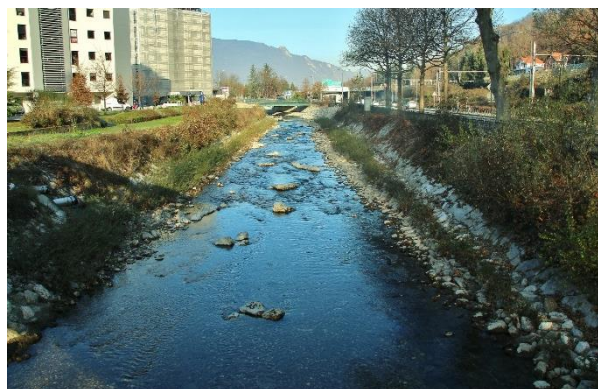
Figure 72 : Exemple de diversification par mise en place de blocs (Giffre et Laysse)
