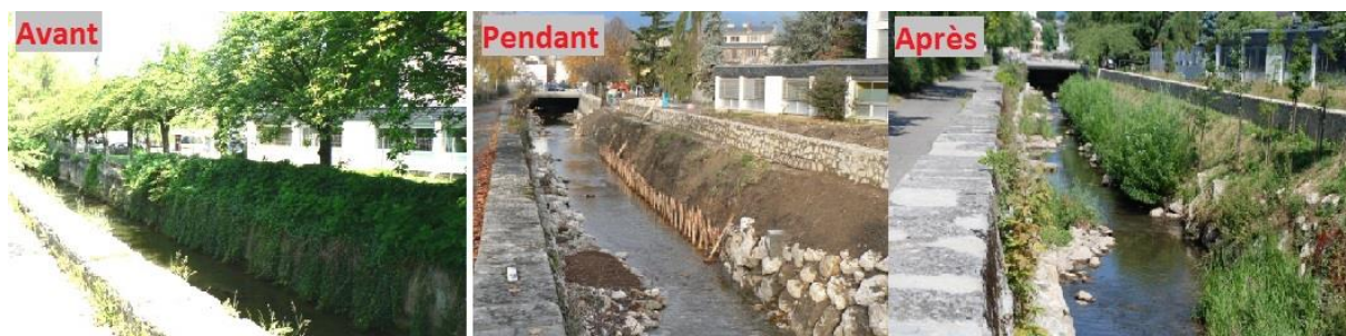
Figure 66 : Reprofilage, engraissement et banquettes sur la Leysse (Chambéry Métropole)
