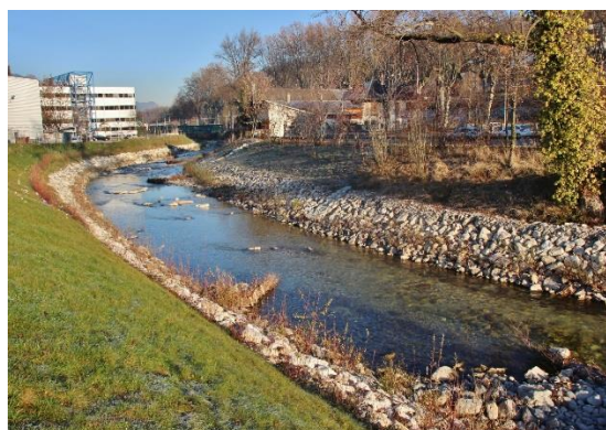
Figure 56 : Reprofilage des berges et diversification du lit de la Lysse (Pêcheurs Chambériens)
