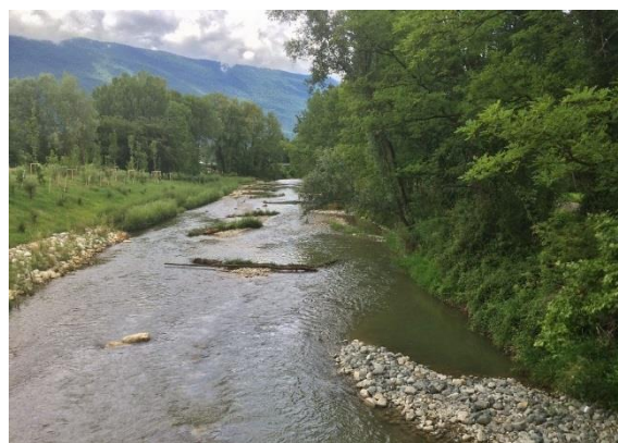
Figure 55 : Adoucissement de la berge RG, diversification du lit et plage de graviers sur la Lysse (Pêcheurs Chambériens)
