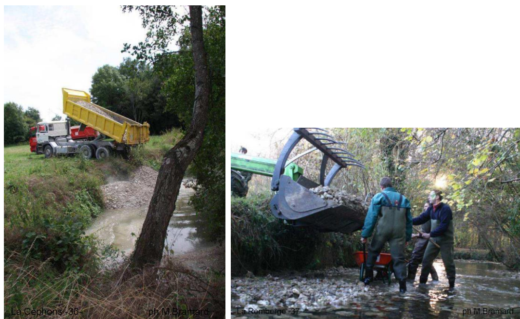
Figure 59 : Exemples d'actions de recharge granulométrique sur des cours d'eau similaires (ONEMA)
