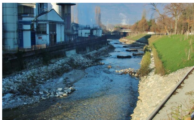
Figure 56 : Reprofilage des berges et diversification du lit de la Lysse (Pêcheurs Chambériens)
