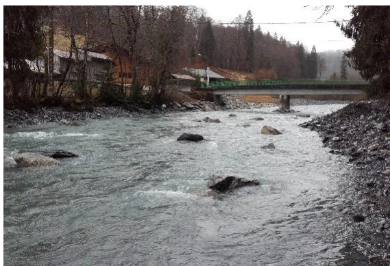
Figure 72 : Exemple de diversification par mise en place de blocs (Giffre et Laysse)
