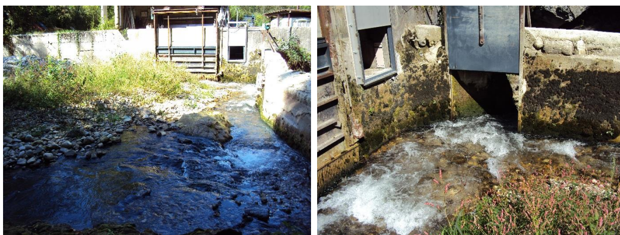
Figure 22 : Les prises d'eau et l'atterrissement en amont du barrage / Les deux veines d'eau qui se rejoignent au pertuis
