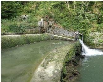
Commentaire : Obstacle naturel équipé. Prise d'eau latérale équipée d'une grille dont l'écartement des barreaux est > 15 cm. Suit une vanne levante manuelle qui contrôle le débit prélevé. Dans le prolongement aval de la prise d'eau, au niveau du seuil, se positionne une vanne de dégrèvement manuelle qui permet également de restituer le Qr (351 l/s).
