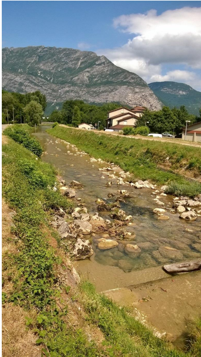
Figure 190 : Furon à Sassenage (FUR030) - Vue aval - Seuil visible en bas de la photo
